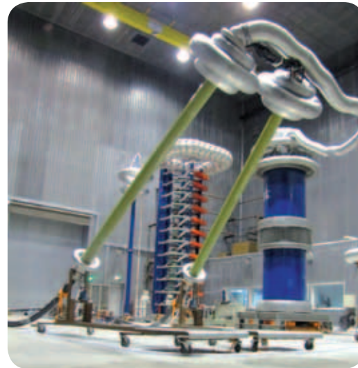
Typprüfung an einem 500-kV-Kabelsystem Type test on a 500-kV cable system
