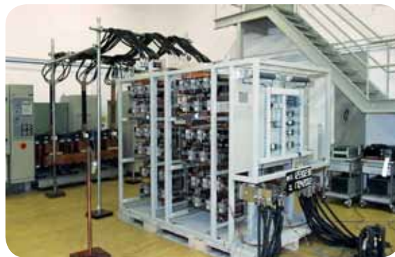
Prüfung an einem Bahngleichrichter Test on a railway rectifier
