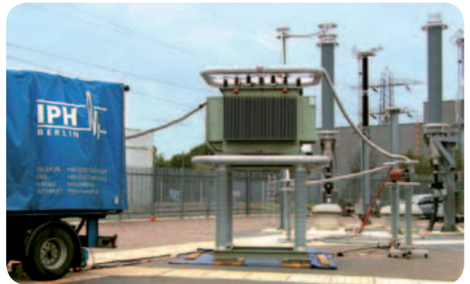
Inbetriebnahmeprüfung mit TE-Messung an einem 280-kV-Kabelsystem in Großbritannien/Commissioning test with PD measurement on a 280-kV cable system in Great Britain
