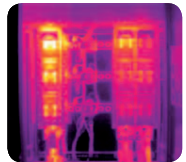
Erwärmungsprüfung an einem Verteilerschrank/Temperature-rise test on a distribution panel
