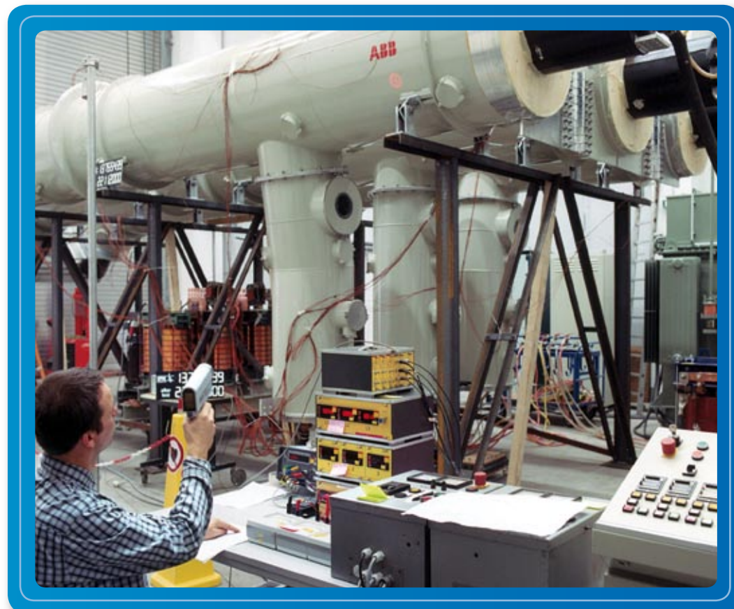
Erwärmungsprüfung an einer Generatorausleitung/Temperature-rise test on a generator bus duct
