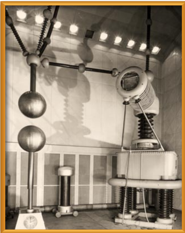
Erste Hochspannungshalle/First high-voltage hall
